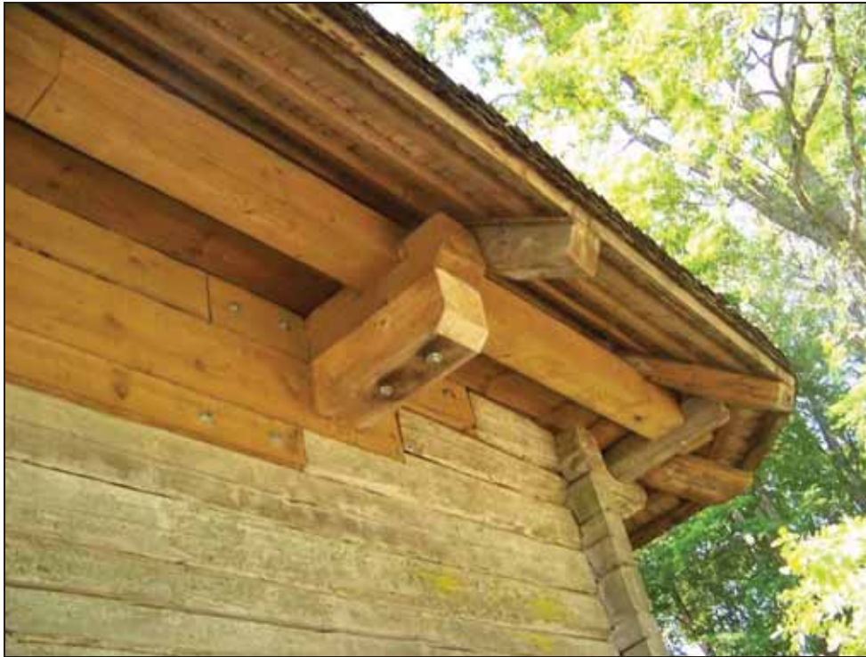
Vecpiebalgas vidus kapu kapliča, protezētie sienu balņi, spārenīcas un spāres. Foto: I. Virse
