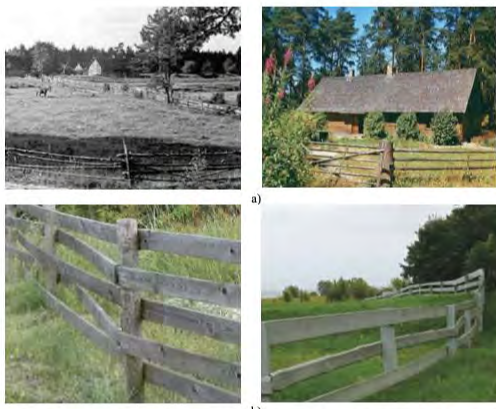
5.3.1.15. attēls. Iespējamie nožogojuma risinājumi: a) Viensētas tradicionāls nožogojums – kāršu žogs. Vēsturiski veidots no nekalibrētiem materiāliem; b) Mūsdienās zemu nožogojumu jeb sētu veido izmantojot dēļus, kā arī kalibrētu materiālu akurātākam izskatam.
