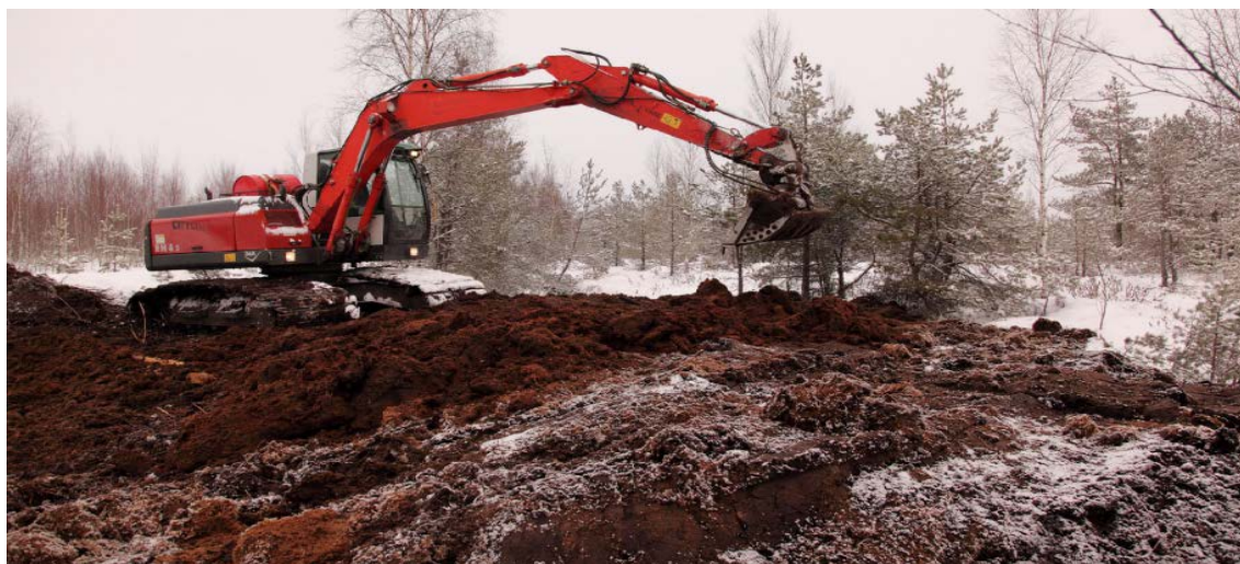
4.2. attēls. Kūdras aizsprosta būvēšana dabas liegumā „Melnā ezera purvs” 2012. gadā. Foto: M. Pakalne.
