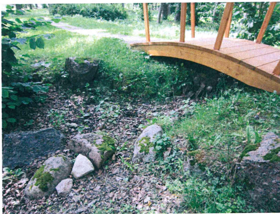
72.att. Vēsturiskais akmens tiltiņa fragments, kurš nav rekonstruēts, bet nosegts ar jaunu konstrukciju, 2014.gada augusts /foto – V.Radziņa/.
