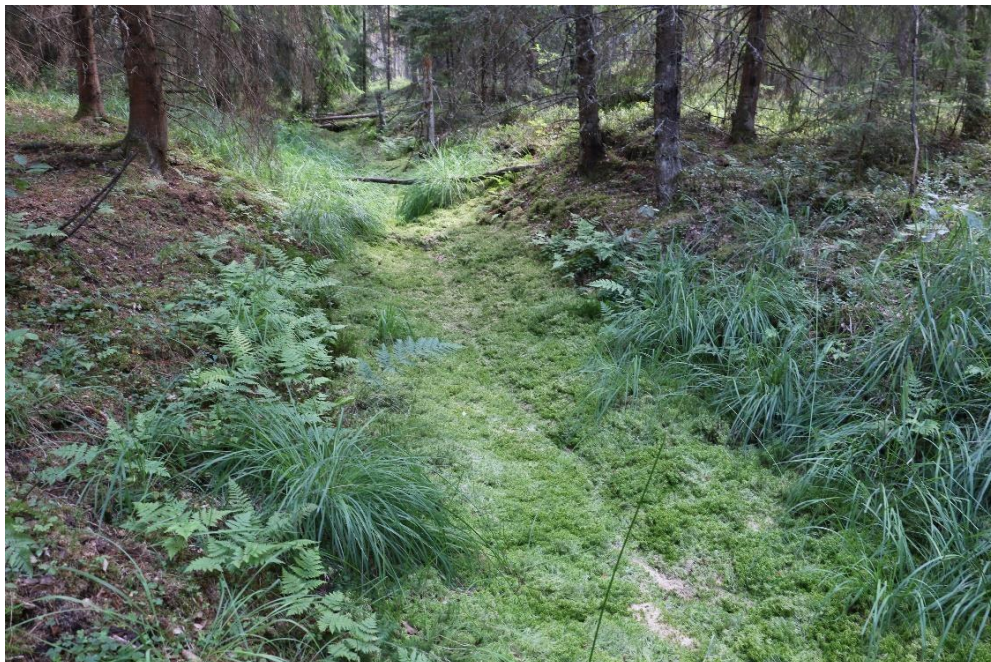
10.6. attēls. Ar sfagniem un grīšļiem dabiski aizaudzis 20.gs. 80.-jos gados veidots susinātājgrāvis purvaino mežu masīva A daļā, kurā vērojama ūdens uzkrāšanās, bet vizuāli nav konstatējama ūdens plūsma (foto: J. Soms, 2021)
