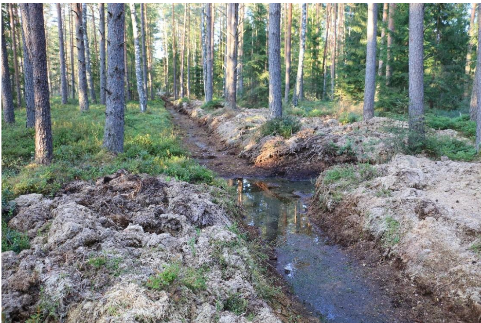
3.6. attēls. Atjaunoti meliorācijas sistēmas grāvji Baukalna purva D malā pie Boku mājām, kas aizvada ūdeņus ārpus purva; ūdens plūsma konstatējama arī vasaras mazūdens periodā (foto: J. Soms, 2021)
