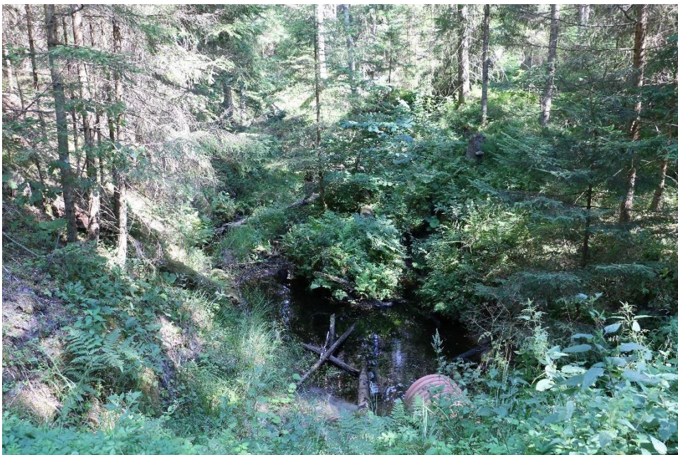
9.6. attēls. Rekonstruētā caurteka un ūdenstece uz A no ceļa Tavaiņi-Klucīšu dzirnavas. Ūdens notece norisinās arī vasarā, mazūdens periodā (foto: J. Soms, 2021)
