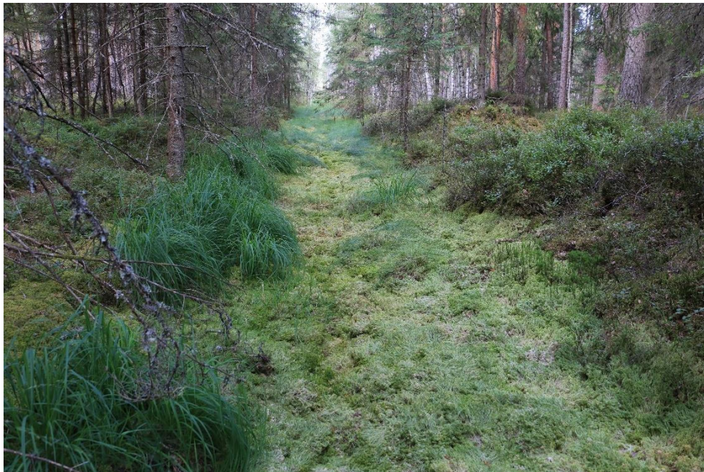
10.5. attēls. Ar sfagniem, grīšļiem un spilvēm dabiski aizaudzis 20.gs. 80.-to gadu meliorācijas sistēmas susinātājgrāvis purvaino mežu masīva A daļā, kurā vērojama ūdens uzkrāšanās, bet vizuāli nav konstatējama ūdens plūsma (foto: J. Soms, 2021)
