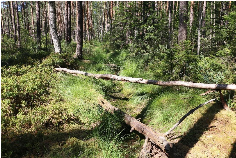
9.2. attēls. Piesērējies un daļēji aizaudzis meliorācijas sistēmas grāvis Tavaiņu purva A malā, kas novada ūdeņus uz Purvupīti. Grāvī vērojama ūdens uzkrāšanās, bet vizuāli nav konstatējama ūdens plūsma (foto: J. Soms, 2021)
