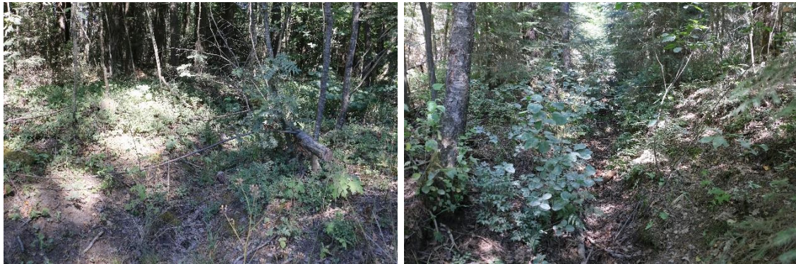
2.2. attēls. Daļēji piesērējuši meliorācijas sistēmas grāvji Baukalna purva D malā, kas aizvada ūdeņus ārpus purva (foto: J. Soms, 2021)
