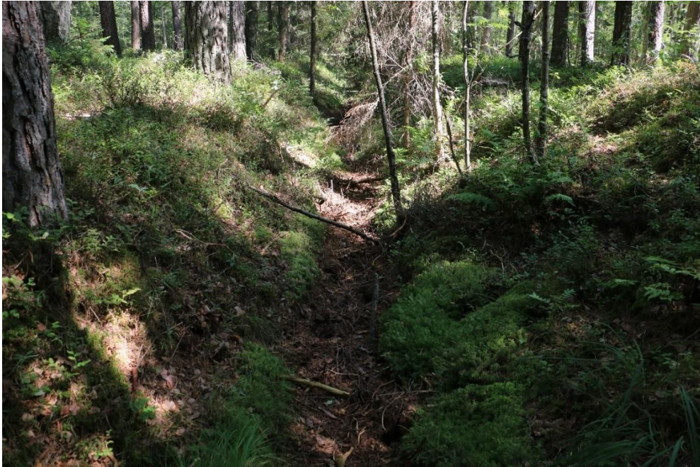
8.2. attēls. Daļēji piesērējis meliorācijas sistēmas grāvis Tūtes purva ZR malā, kas novada ūdeņus uz aizaugošo Anuļu ezeru (foto: J. Soms, 2021)
