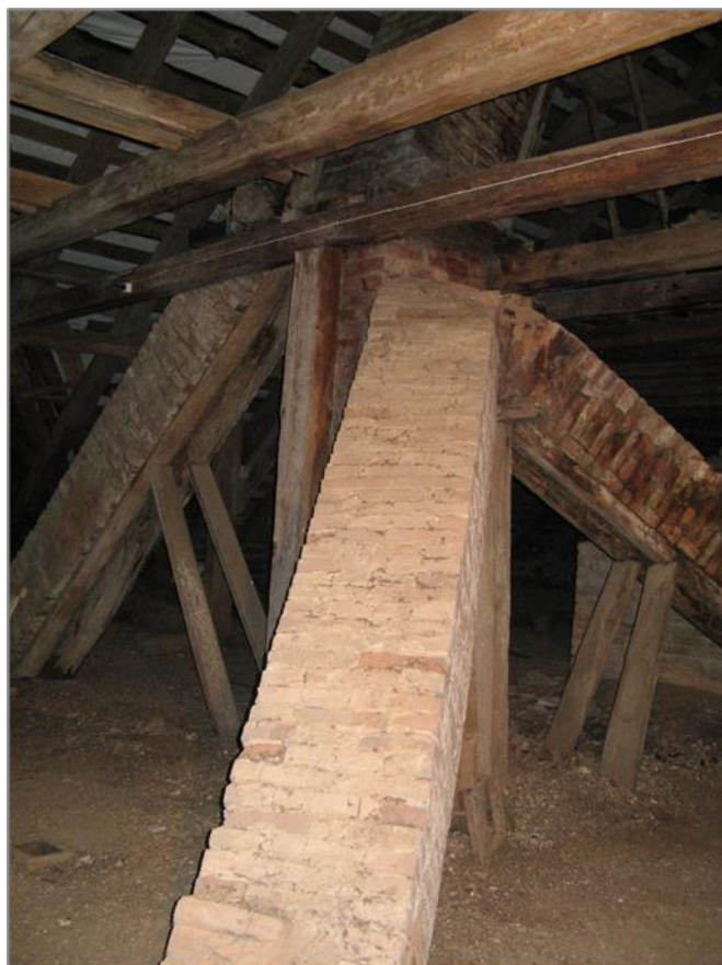
Dūmkanālu pārvadi bēniņu telpā.
