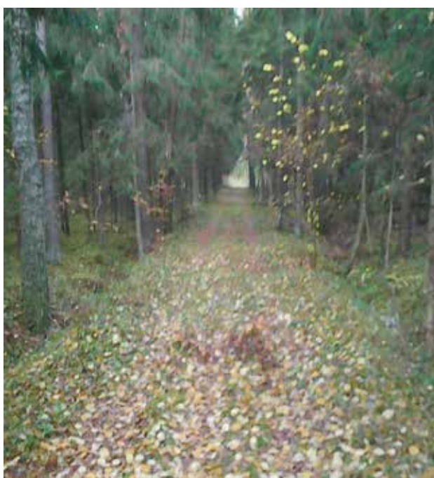
Aizsargdambja trase tā piketā 8/00. Dabā pastāv uzbērumš. Nepieciešams paaugstināt tā virsas atzīmes.
