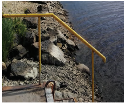
Piestātnes metāla margas ar atlupušu dzeltenu krāsojumu
