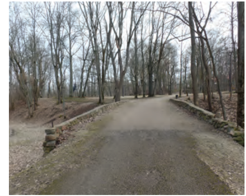
Akmens tilta atbalsta sienīņa 40 cm augsta
