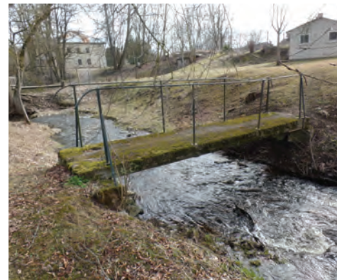
Betona plāksne - tilts pār Rumbiņu ar metāla margu
