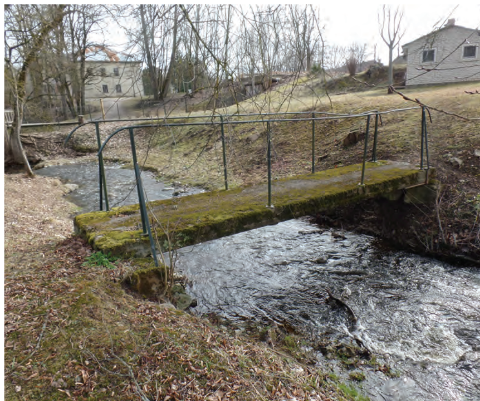
Mazais tilts pār Rumbiņu, ko veido betona plāksne, demontējams, tā vietā uzstādāms neliels koka tiltiņš
