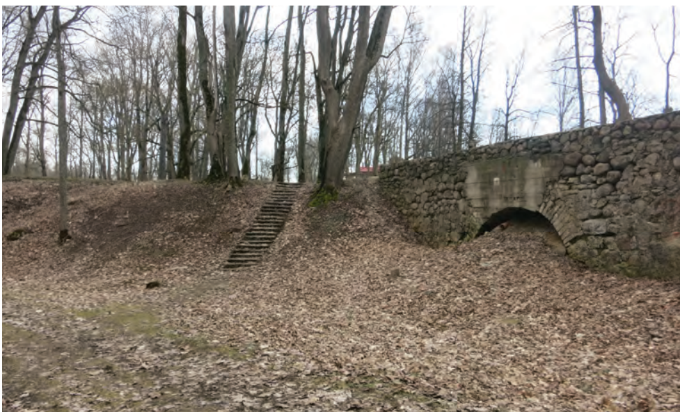
Skats uz tiltu 2019. gada aprīlī. Gandrīz no tās pašas vietas
