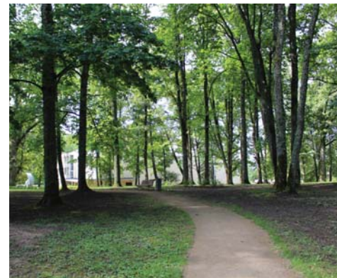
Nesen ierīkotais gājēju celiņš ar grants segumu un plastmasas apmalēm
