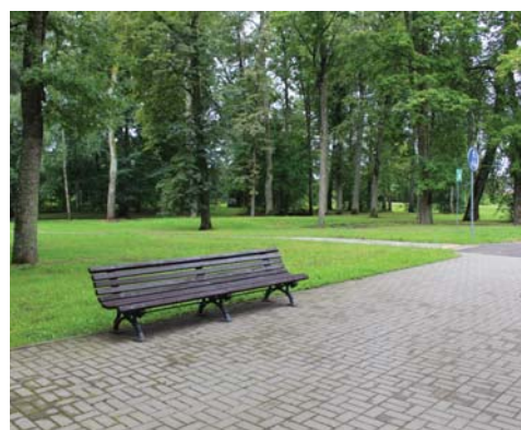
Betona bruģakmens laukums
