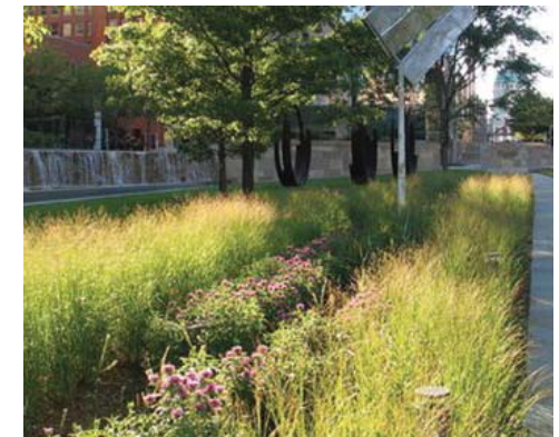
Ar graudzālēm un ziemcietēm nostādītas grāvja nogāzes un gultne
