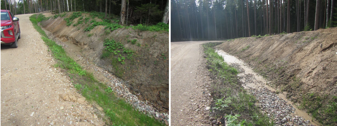
5.6. attēls. Nogāžu un sāngrāvju gultņu izskalojumi meža ceļos
