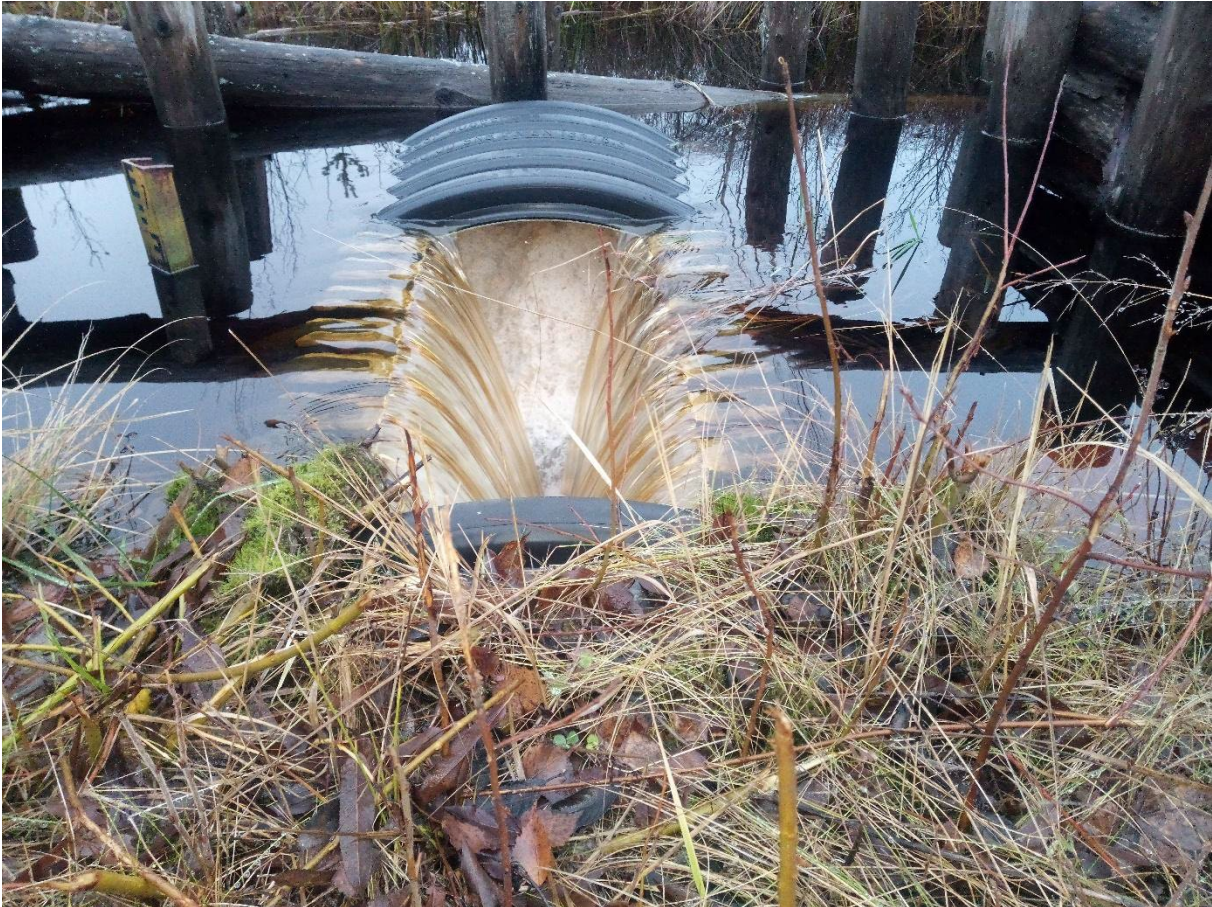
5.10. attēls. Regulators ūdens līmeņa uzturēšanai teritorijā, kurā nav pieļaujama nosusināšana. Foto: U.Bergmanis, no atzinuma UB/2016/4 "Par autoceļa P62 Krāslava – Preiļi – Madona (Atašiene – Ļūmāni) pārbūves ietekmi uz dabas lieguma "Eiduku purvs" un Teiču dabas rezervāta Eiropas Savienības nozīmes prioritārajiem biotopiem
