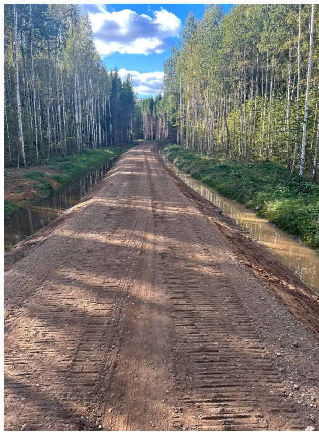
5.5. attēls. Ceļa trase minimālajā tehniski iespējamajā platumā slapjos apstākļos, ceļa klātne 3,5 m, trase ~12 m. MAC "Aizkraukles purva ceļš"
