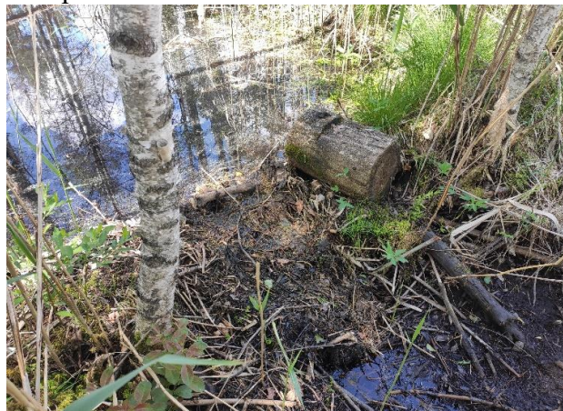
13. attēls. Aizsprosts uz grāvja Šņitkas purvā. Foto:Evita Oļehnoviča (02.06.2023.)
