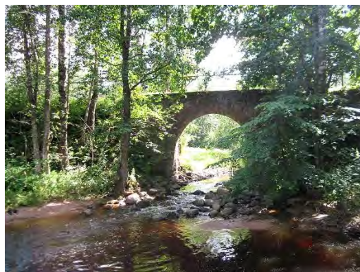
10. attēls. Skats uz Pogulānkas arkveida akmens tiltu (foto https://www.visitdaugavpils.lv/turisma-objekts/pogulankas-salienas-upe-un-arkveida-akmens-tilts/ ).
