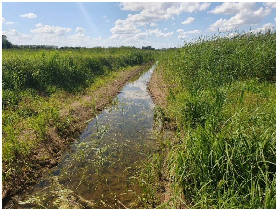
2.10. attēls. Pasākumi hidroloģiskā režīma uzlabošanai II teritorijā – atjaunots grāvis ar lēzenu profilu, apvienojumā ar regulatoru pie ietekas Platones upē (foto – A. Pošiva-Bunkovska)
