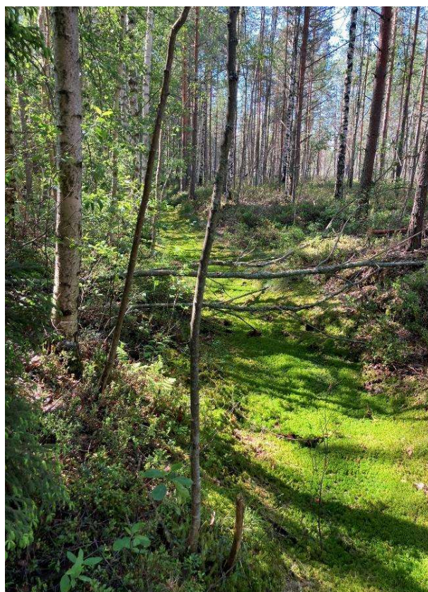
17. Att. Stigas grāvja stāvoklis
