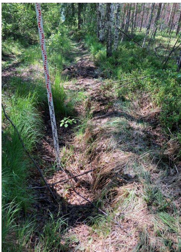
21. Att. Grāvja stāvoklis
