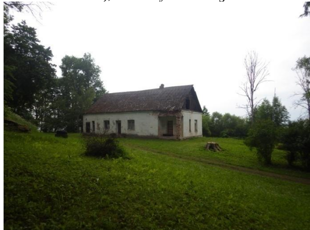
128. att. Vīsraga taka Burtnieku parka Z malā pie pilsdrupām un lieguma robežas takas malā – skats ZR virzienā uz taku un pamesto māju Ezera ielā 2 (skatu punkta koord. 395915N/576252E), U.Suško foto 2024. gada 24. oktobrī.
