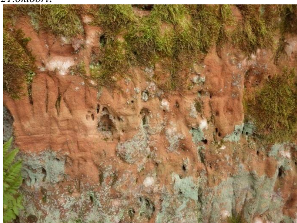
35. att. Otrais smilšakmens atsegums – Kapu klints (8220, 18DO167_2) Burtnieka DAA stāvkrasta nogāzē Veco kapu DR malā – skats no stāvkrasta nogāzes lejasdaļas DAD virzienā uz atseguma Z daļu un seniem uzrakstiem un skrāpējumiem (skatu punkta koord. 397541N/577460E), U.Suško foto 2024. gada 21.oktobrī.
