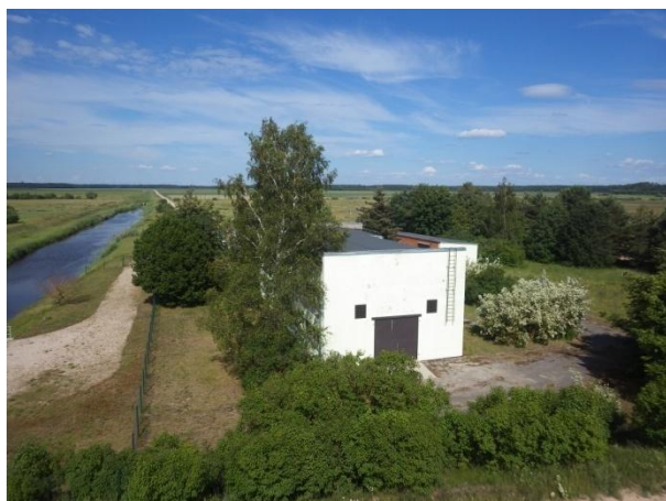
54. att. Burtnieka A krasts pie lieguma robežas, Silzemnieku Ziemeļu pļavas, Lielā grāvja un sūkņu stacijas vasarā – skats no Silzemnieku skatu torņa uz ZAA (skatu punkta koord. 401471N/576854E), U.Suško foto 2024. gada 18. jūnijā.
