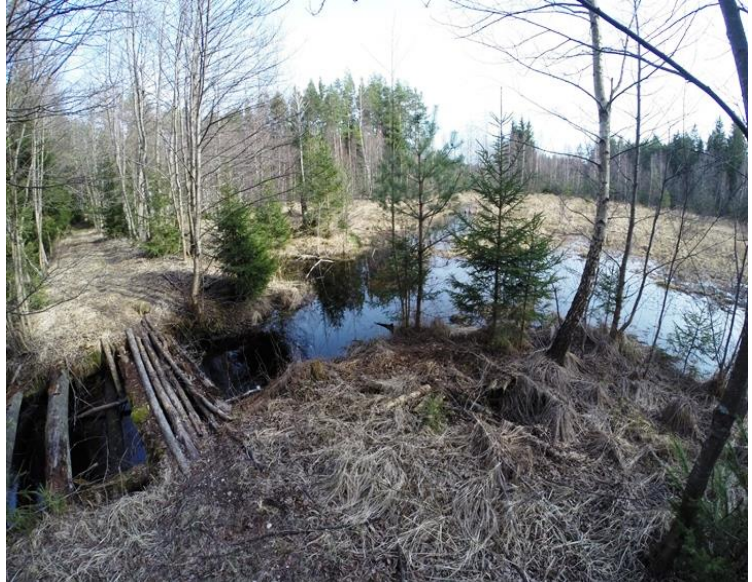
8.attēls. Zaķu valks un nefunkcionējošs tilts pār to Foto: E.Dzenis, 2015
