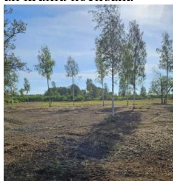
Zemsedzes frēzēšana, līdzinot zālāja virsmu, izmantojot ekskavatoru ar virspusējo (vieglo) frēzi. 2023.g. augusts
