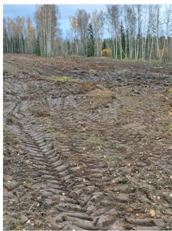
Novāktā apauguma- celmu un sakņu frēzēšana ar rekultivācijas frēzi. 2022.gada oktobris
