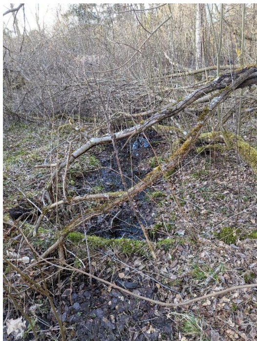
17. attēls. Atjaunojamais grāvis aizsērējis, ar sakritušiem kokiem (x=352646, y=306933).
