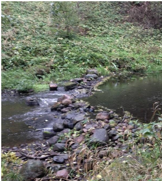
21. attēls. Otrais aizsprosts – akmeņu krāvums – uz Istras upes augšpus Meļņiku aizsprosta caurtekas-regulatora 2024.gada rudens (2024-09-28, LKS92 x: 747393.1, y:243157.7; skats: A virzienā; autors: A.Kalvāns)
