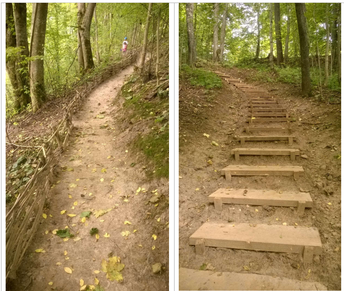
1.4.1. attēls. Tūrisma taku infrastruktūra dabas liegumā „Pilskalnes Siguldiņa” (pa kreisi – ar pītu klūgu apmali nostiprināta taka; pa labi – dēļu kāpnes)
