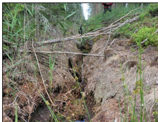
Iegrauzums pie grāvja izplūdes galvenajā meliorācijas grāvī, ūdens līmeņu starpība grāvjos ap 0,7-1,0 m
