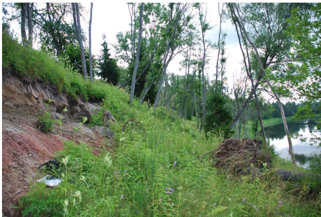
1.8. attēls. Nogāžu izciršana, kuras rezultāta pastiprinās krastu erozija
