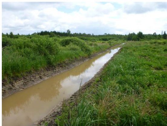
Vatstrauts, skats uz DA. Grāvis pilns ar ūdeni pēc iepriekšējās dienas lietus. Mālaina grunts. Grāvji nesen tīrīti un padziļināti (A.Dēliņas foto, 08.07.2015.)
