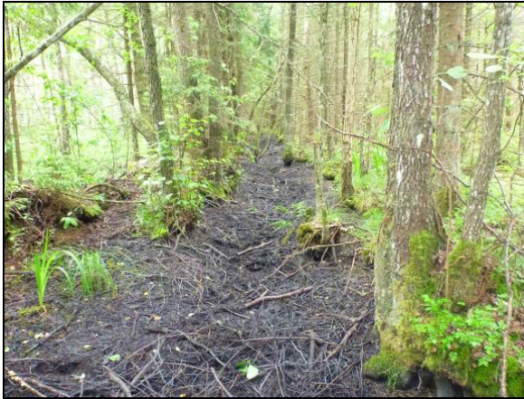
Sauss, aizsērējis grāvis gar Grīvu purva A malu, grāvja Z gals. Grāvī ūdens parādās tikai pie augsta ūdens līmeņa, pavasaros, rudenos. Faktiski grāvis nefunkcionē (A.Dēliņas foto, 07.07.2015.)
