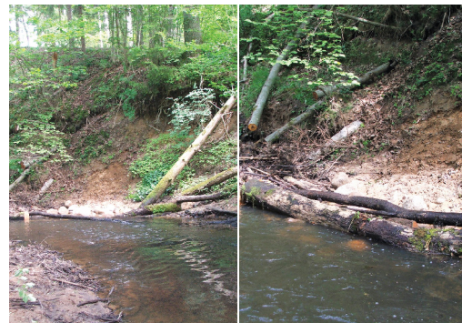
17.32. att. Krasta nostiprināšana ir veikta, lai apturētu krasta eroziju un nepieļautu nogāzē augošā ozola iegāšanos upē (1). Erodētais krasts sākotnēji ir aizpildīts ar akmeņiem (2) un tad nostiprināts ar krastam paralēli novietotiem kokiem. Kauliņa. Alsungas novads. Foto: A. V. Urtāns.
