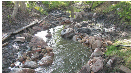
Pēc krastu nostiprināšanas ar akmeņiem ir pārtraukta krasta noskalošanās un pastiprinātu sedimentācijas procesu norise. Foto: A.V. Urtāns.
