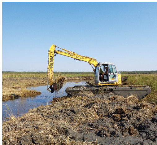
13.11.att. Vienlaidus niedrājā tiek veikta kanāla rakšana, lai atjaunotu ūdens cirkulāciju un ūdens organismu migrāciju. Engures ezers. Foto: J. Reihmanis.
