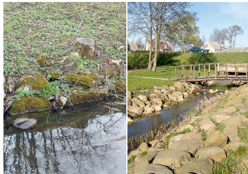
17.31. att. Erozijas mazināšanas nolūkā ar akmeņiem nostiprināti krasti. (1) Ar akmeņiem nostiprinātā upes krastā ar laiku ir izveidojušās arī ūdens un sauszemes organismiem piemērotas dzīvotnes. Lazdupe Rankā. Foto: L. Urtāne. (2) Pilsētvidē esošām upēm krastu nostiprināšanu kombinē ar vides elementu izveidi. Stulpas upe Lietuvā. Krastā redzamais izvietoto akmeņu apjoms ir lielāks, nekā nepieciešams, lai nostiprinātu upes krastus. Foto: A. V. Urtāns.
