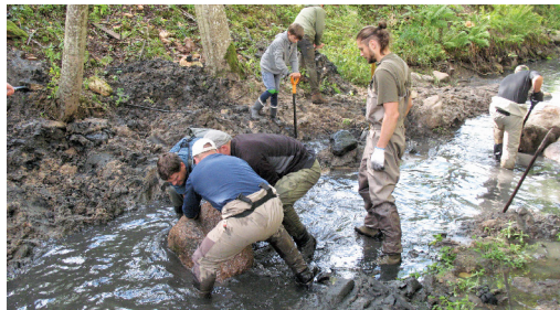
Upes gultne tiek sašaurināta, tās krastos izveidojot akmeņu stiprinājumu. Foto: A.V. Urtāns.
