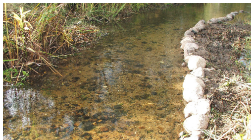
Ar akmeņu palīdzību ir sašaurināta upes gultne, tā palielinot straumes ātrumu un pārtraucot pastiprinātas sedimentācijas procesus. Gaujas atteka Jaunpiebalgā. Foto: L. Urtāne.
