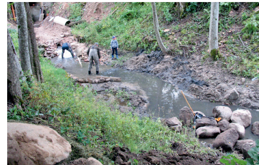
17.33. att. Upes gultnes sašaurināšanas paņēmieni. (1) Mazproduktīvs ūdensteces posms ar platu un seklu, sedimentiem klātu gultni pie Kārļu zivjaudzētavas pirms gultnes sašaurināšanas darbu veikšanas (2) Ar akmeņu rindas palīdzību ir sašaurināta ūdensteces gultne, tā radot lielāku straumes ātrumu un atjaunojot agrāko dziļumu. Pēc sanešu izskalošanās upē veidosies daudzveidīgas mikrodzīvotnes un atjaunosies lašveidīgo zivīm piemērotas uzturēšanās vietas. Starp krastu un akmeņiem esošajā sanešu joslā turpmākajā periodā izveidosies zālājs. Foto: A. V. Urtāns.
