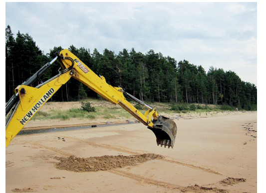
Ar smiltīm aizskalotā upes ieteka tiek tīrīta izmantojot ekskavatoru. Kurliņupe. Foto: G. Rubenis.
