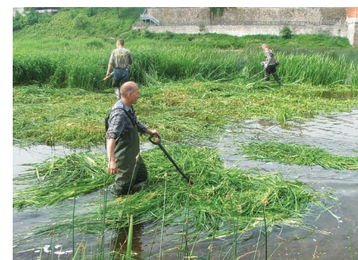
17.26. att. Ūdensaugu plaušana un izvākšana no ūdens Ventā, izmantojot roku darbu. Plaušana tiek veikta ar trimmeri.
