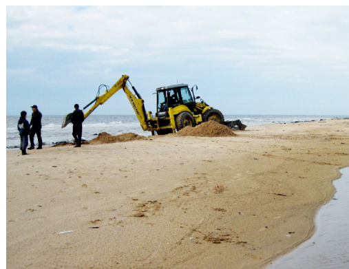
Ar ekskavatoru izrakstā smilts tiek izlīdzināta upei piegulošajā liedaga teritorijā. Kurliņupe. Foto: G. Rubenis.
