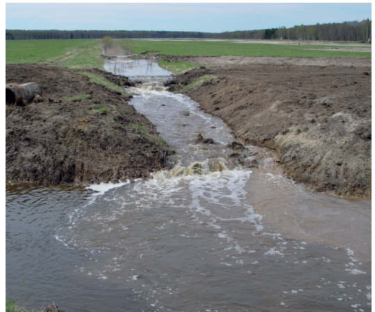
21.6.8. att. Sliekšnis uz Slampes upes, lai paceltu ūdens līmeni. Foto: G. Pāvils.
