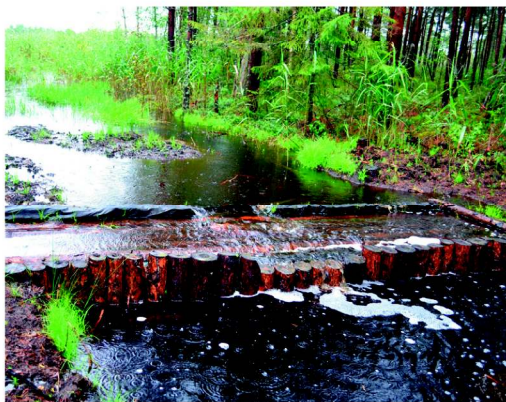
10.27. att. Koka aizsprostu Somā purvā Igaunijā veido divas perpendikulāri grāvim iedzītu balķu rindas, ko aizpilda kūdra, kas virspusē nostiprināta ar dēļiem, bet augšpus aizsprosta tas izolēts ar izturīgu plastikāta plēvi. Foto: S. Ikauniece.
