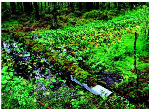
10.34. att. Ar sūnu klājumu nomaskēts plastmasas aizsprosts, lai panāktu tā ātrāku apaugšanu un iekļaušanos dabiskajā ainavā. Kamanu rezervāts Lietuvā.
