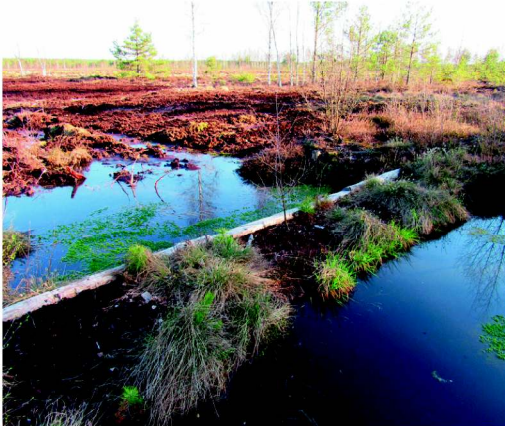
10.29. att. Koka aizsprosts no balķiem, augšpus aizsprostam noblīvēts ar kūdras slāni, Vīru purvā Igaunijā. Foto: A. Priede.
