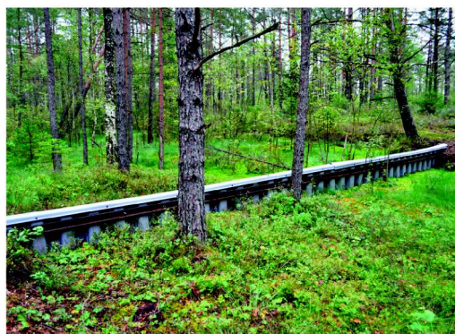
10.33. att. Aizsprosts, kas būvēts no plastmasas rievsienu pāri platam grāvim Kamanu rezervātā Lietuvā. Foto: S. Ikaunieca.
