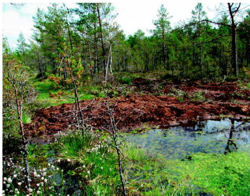
10.41. att. Ar ekskavatoru pirms dažiem mēnešiem būvēts kūdras aizsprosts Rožu purvā (2013. gads). Foto: A. Priede.
