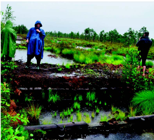
10.30. att. Koka aizsprosts, kas aizpildīts ar kūdru purvā Igaunijā. Foto: S. Ikauniece.
