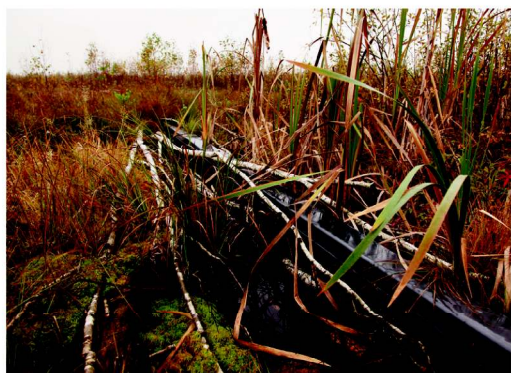
10.32. att. No plastmasas rievsienu veidots aizsprosts izstrādātā kūdras purvā Žuvintas rezervātā Lietuvā. Foto: M. Pakalne.
