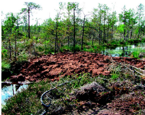
10.39. att. Ar ekskavatoru nesen būvēts kūdras aizsprosts Rožu purvā. Aizsprosta virsa veidota augstāka par purva virsu, paredzot kūdras sēšanas. Foto: A. Priede.
