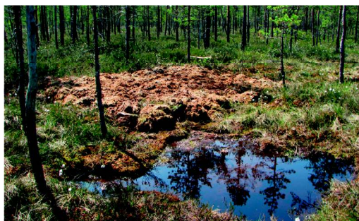
10.37. att. Ar rokām būvēts kūdras aizsprosts Aklajā purvā (2013. gads). Kūdra iegūta izgrieztu velēnu veidā blakus aizsprostam, izrokot to no purva virsas. Foto: A. Priede.
