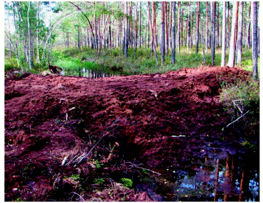
2.10. att. Nesen uzbūvēts kūdras aizsprosts uz grāvja Rožu purvā 2013. gadā. Foto: A. Priede.
