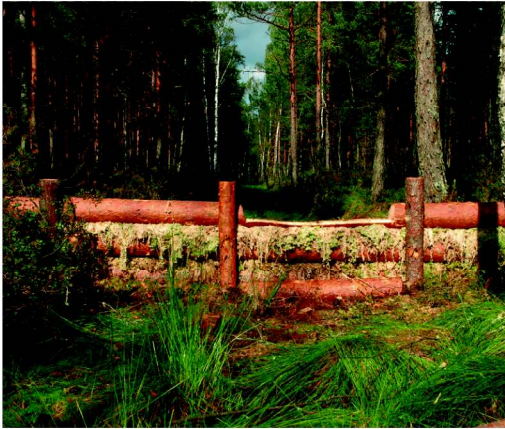
10.28. att. Balķu aizsprosts, noblīvēts ar sfagniem, Teiču purva Rāksalā 2004. gadā. Foto: J. Jātnieks.
