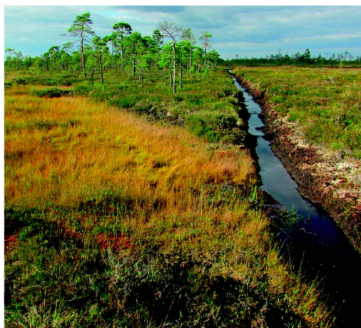
10.47. att. Lai ierikotu kūdras frēzlauku, nesen izrakts kontūrgrāvis Aizkraukles purvā gar plānotā kūdras frēzlauka malu un neskartā purva malu. Hidroizolējoša membrāna būtu jāierīko paralēli kontūrgrāvim, pirms būtiski pazemināts ūdens līmenis plānotajā kūdras ieguves laukā, t. i., reizē ar pirmajiem kontūrgrāvjiem. Foto: A. Priede.
