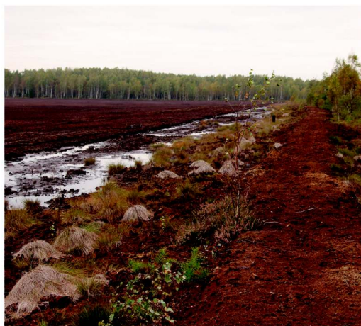
10.46. att. No plastikāta plēves veidota hidroizolējoša siena, ko nosedz kūdras dambis gar izstrādāta purva malu Aukštumalas purvā Lietuvā. Foto: M. Pakalne.
