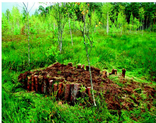
10.38. att. Ar rokām būvēts kūdras aizsprosts 2013. gadā Aizkraukles purvā uz neliela, gandrīz aizauguša grāvja. Aizsprosta malas nostiprinātas ar koka pāļiem. Foto: A. Priede.
