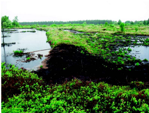
10.60. att. Kūdras valnis, kas kalpo kā aizsprosts purvā uz nogāzes Vācijā. Foto: K. Lapiņš.
