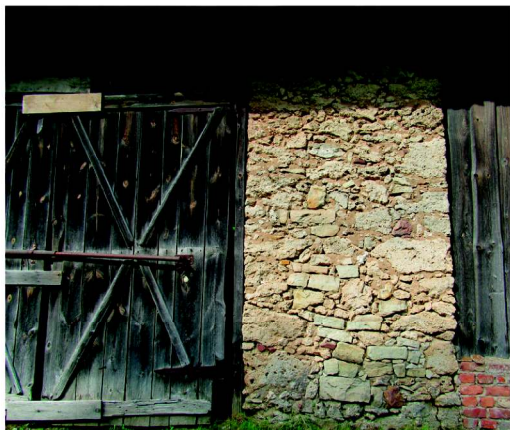
2.5. att. No sūnakmens un kaļķakmens gabaliem mūrēta siena senā saimniecības ēkā Ruses mājās pie Matkules, kur Imulas ielejas nogāzēs izplūstošie avoti bagātīgi izgulsnē avotkalķi. Iegūstot sūnakmeni dažādām saimnieciskām vajadzībām, nopostīta lielākā daļa Kauķa kalna jeb Kursas Staburaga, kas kādreiz bijusi plaša avotkalķu atradne. Foto: A. Priede.
