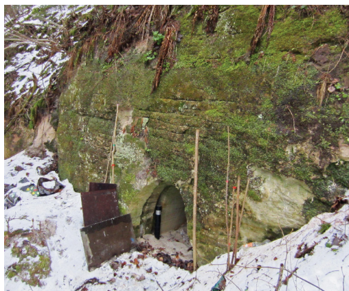
12.13. att. Sen pamestas Līgatnes pagrabalas. Saglabājusies tikai atbalsta sienu kreisajā pusē, ieejas durvis un to stiprinājumi ir pazuduši. Foto: I. Čakare.
