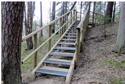
11.30. att. Igaunijā pie Tevaskoje atsegumiem Ahjas upes krastā izveidotas kāpnes ar metāla pakāpieniem, kas kalpos ilgi. Foto: I. Čakare.
