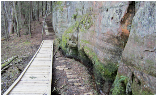
11.22. att. Blakus laipai Liču- Lanču klintīs izveidota taka no koka pakāpieniem. Tie pasargā avotaino vietu no izmīdīšanas, bet apmeklētājiem ir vieglāk nokļūt pie sienas un veidot skrāpējumus. Foto: I. Čakare.
