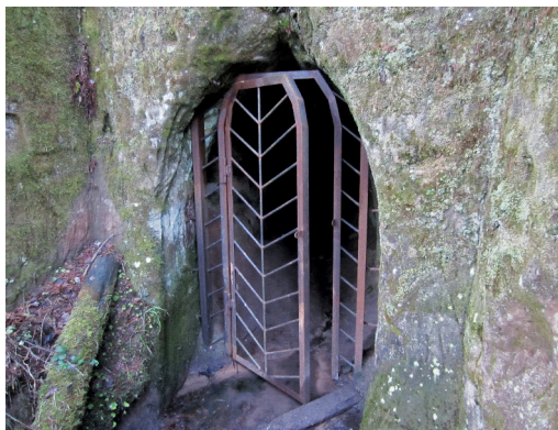
12.8. att. Nepareizi izveidots restojums Līgatnē. Šķērssiņi izveidoti slīpi, nevis taisni. Foto: I. Čakare.
