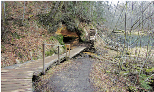
11.21. att. Laipa pirms remonta gar Sarkanajām klintīm pie Cēsīm bija kļuvusi nedroša (slidenā, dēļu gali cilājās, nebija norobežojošās margas), tāpēc apmeklētāji izmantoja iespēju iet gar malu un izmīdīja atseguma pakāji. Foto: I. Čakare.
