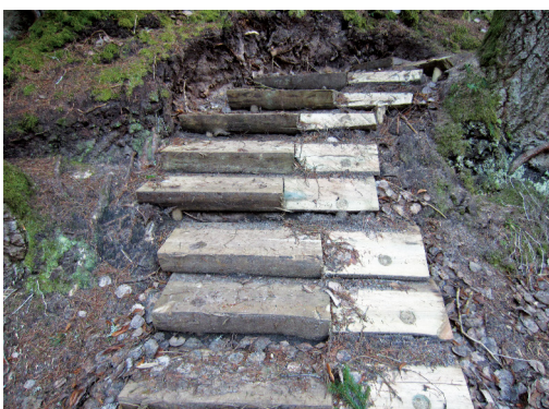
11.29. att. Koka šķīļu kāpnes Liču-Lanģu klintīs jau izveidot sarežģītu konfigurāciju, jo katrs pakāpiens ar koka tapām piestiprināts atsevišķi. Koks ātri nolietojas, bet šos pakāpienus var atjaunot katru atsevišķi. Tomēr šādi pakāpieni mēdz sašķiebties un izslidēt no vietas. Foto: I. Čakare.
