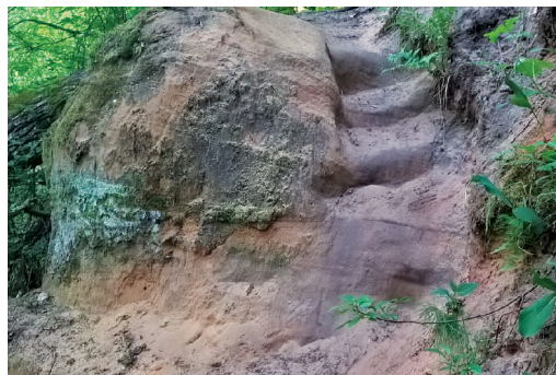
11.33. att. Cēsu Sarkanajās klintīs taka ved pāri atseguma sienai, uz atseguma izveidoti pakāpieni un ir izteikts nomidījums, kas būtiski pasliktina atseguma stāvokli. Fotografēts 2016. gada jūlijā. Foto: I. Čakare.
