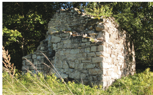
2.5. att. Apkārtnē, kur upju gravās atsedzas karbonātski pamatieži, bieži redzamas celtnes, kurās izmantoti dolomīta gabali (ēka Vaives pagasta Baltiņos). Foto: I. Čakare.
