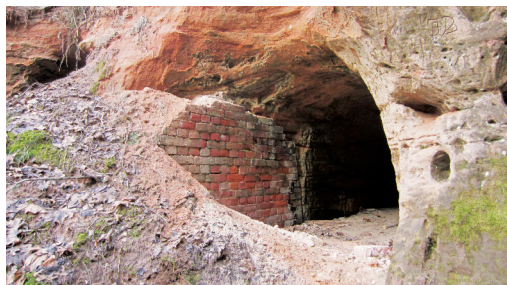
2.6. att. Pamestas Līgatnes pagrabas. Kreisajā malā redzama no ķieģeļiem veidota nostiprinājuma siena. Foto: I. Čakare.
