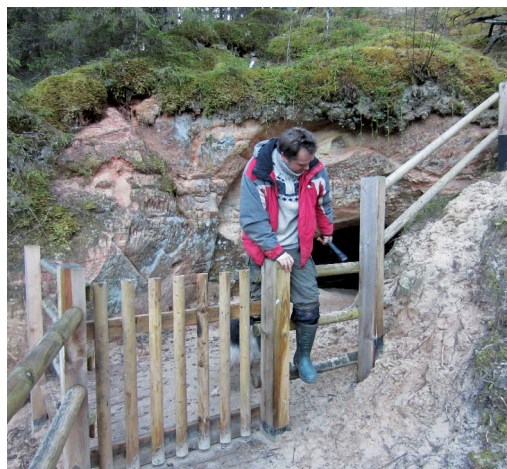
12.12. att. Zemie vārtiņi ļauj saskatīt alu, bet horizontālo norobežojumu ir viegli pārkāpt, tāpēc norobežojuma mērķis pilnībā nav sasniegts. Foto: I.Čakare.
